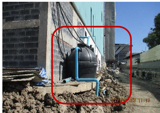
รูปที่ 18 ระบบบำบัดน้ำเสียสำเร็จรูป
